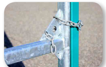
Fixation des barrières par chaînettes amovibles
