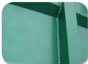
Soudure en continu et non par points
