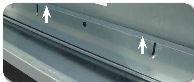
Poignées à soulever pour augmenter le débit de nourriture
