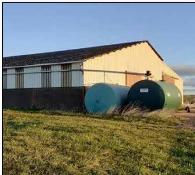
CHEZ UN CLIENT, CITERNE INSTALLÉE AVEC RACCORDEMENT AUX GOUTTIÈRES DU BÂTIMENT
