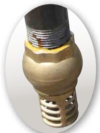
Tube plongeur rigide avec crépine en point bas
