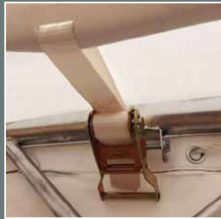
Fixation de la bâche à la structure
