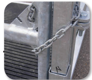
Fixation des barrières sur le montant
