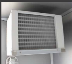
Groupe froid (-4°/+4°) avec gaz Fréon R404A
