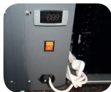
Mise sur tension et réglage du groupe froid
