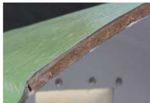
L'isolation est assurée par une couche de deux centimètres de mousse polyuréthane insérée entre les deux épaisseurs de résine et fibre de verre du toit de la niche. - © Beiser
